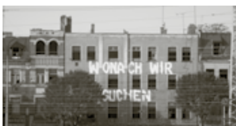
Beschriftung eines leerstehenden Hauses in Halle, 2008 aus dem Zug gesehen
